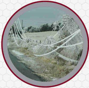
Использование TruPulse сделало оценку ущерба и измерения провисания проводов на всей зоне обслуживания гораздо более эффективными, чем старые методы. Очень важно, что работая с лазером, полевая команда могла находиться в безопасности, проводя измерения.
